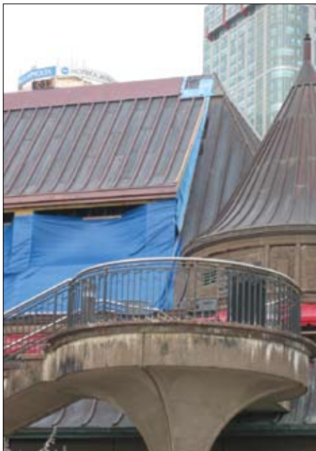
Élément de couverture à joints à baguette, en cours de pose.
