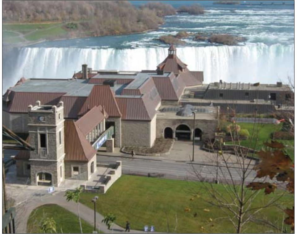
Le complexe terminé, avec les chutes en toile de fond. Photo : Custom Cupola & Steeple Co. The completed project with the Horseshoe Falls in the background.
