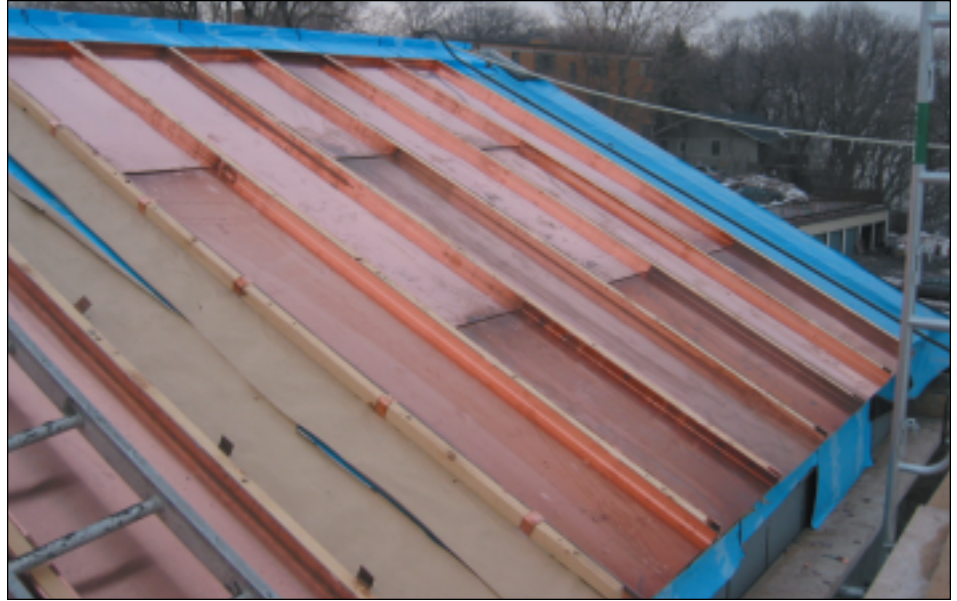
La toiture en cuivre à joints à baguette présente une série de joints décalés et un faîtage détaillé.
