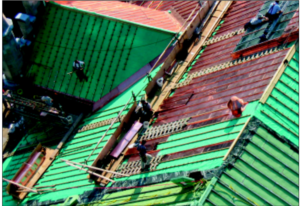
La complexité de cet immense projet est évidente de cette vue à partir du haut de la toiture principale.
