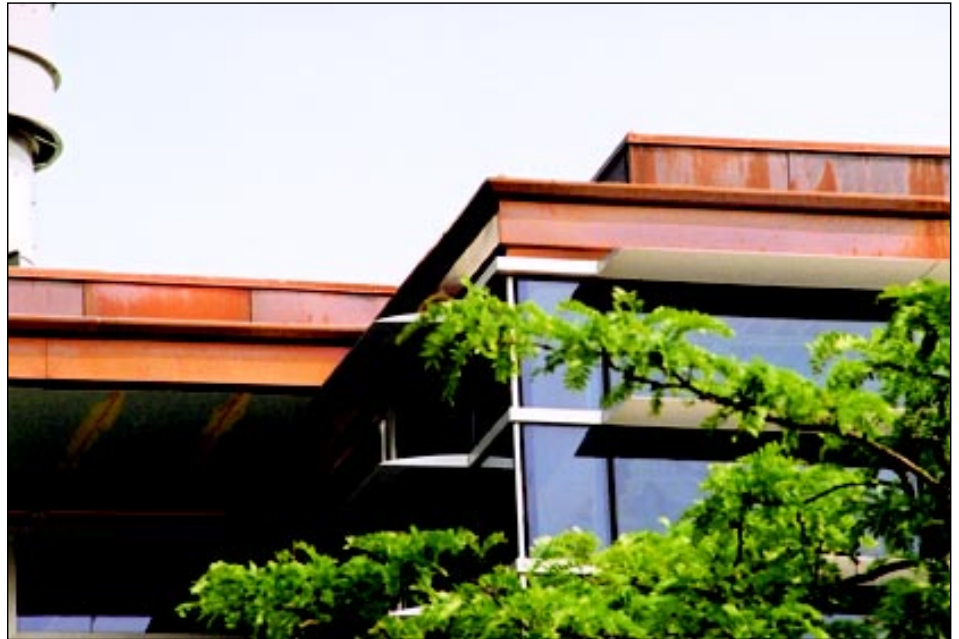
On a utilisé du cuivre partout dans le projet et pour les détails tels que les solins et les parapets. Copper was used throughout for details such as parapets and flashings.
