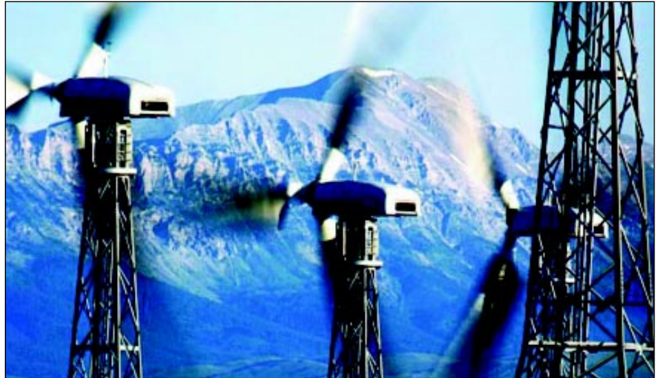
Des éoliennes dans la région de Pincher Creek en Alberta, une des régions les plus venteuses du Canada. La photo est la courtoisie de Wind Power Inc.
